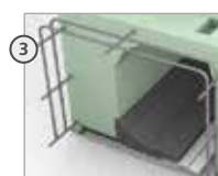
Stabilisateur comblés par mousse expansive
